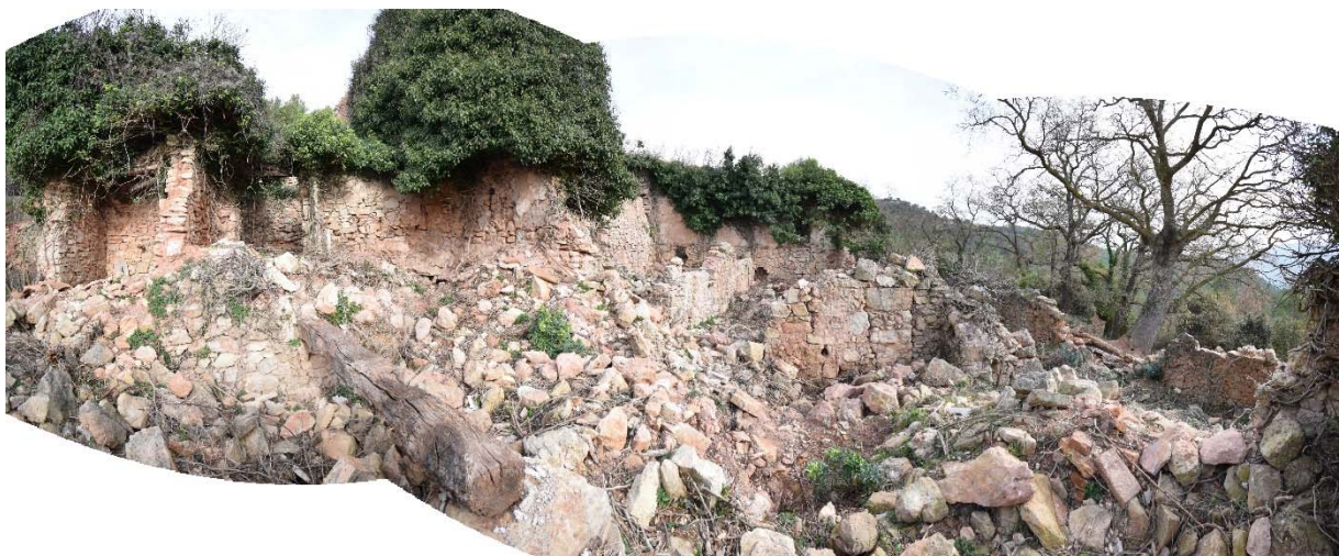
Foto 07. Vista interior panoràmica.
