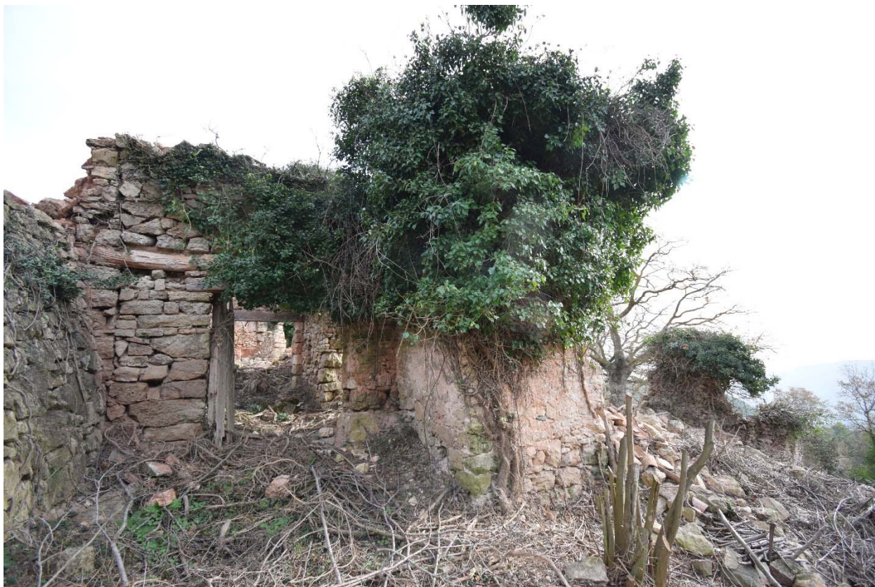
Foto 00. Vista entrada oest
