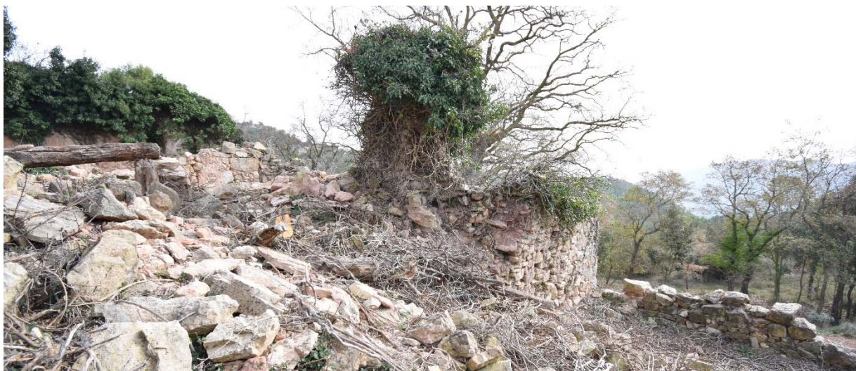
Foto 05. Vista interior sector oest
