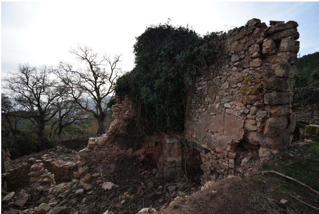
Foto 04. Vista des de façana nord
