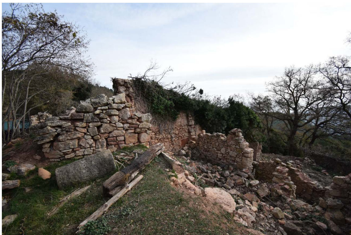
Foto 03. Vista des de façana nord
