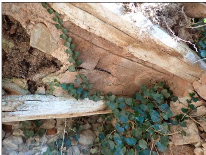
Foto 62. Forjat de biga i revoltons de guix preservat a l'interior de l'àmbit G.
