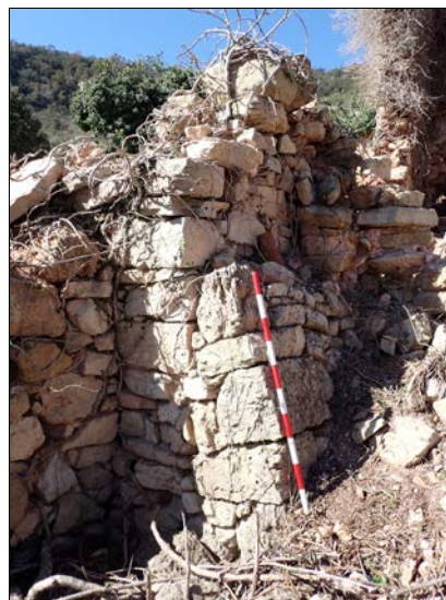
Foto 49. Contrafort 1041 i estructura angular 1042.
