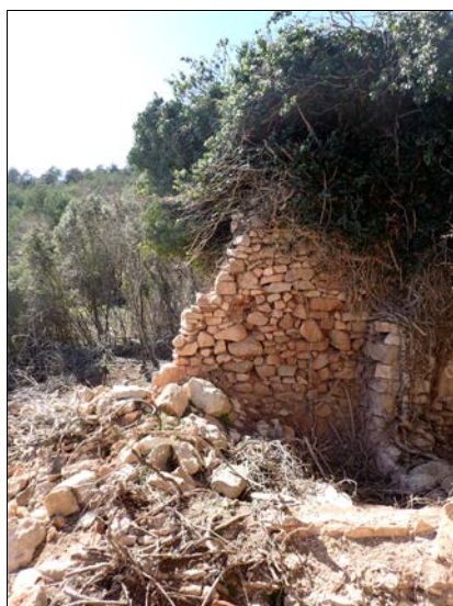
Foto 46. Restes del mur de façana 1009 i de la porta 1055 (a l'extrem dret).
