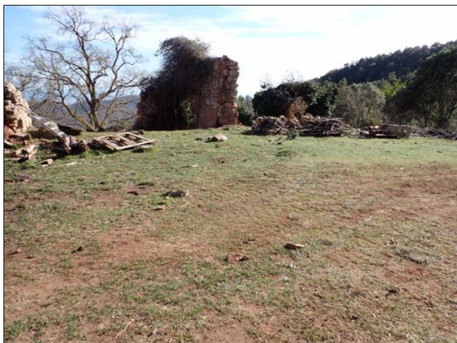
Foto 5. Era situada al costat nord de l'edifici, a la part més alta i més ben ventilada.
