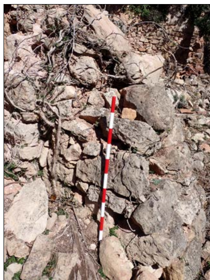
Foto 52. Vista lateral del contrafort 1040 i brancal NE de la porta 1045.
