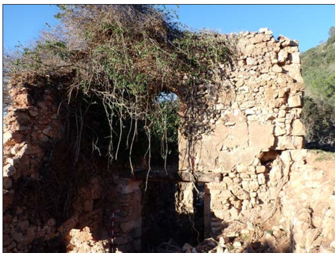
Foto 7. Cantonada SO: mur de façana 1005 (dreta) i mur lateral 1020 (esquerra).
