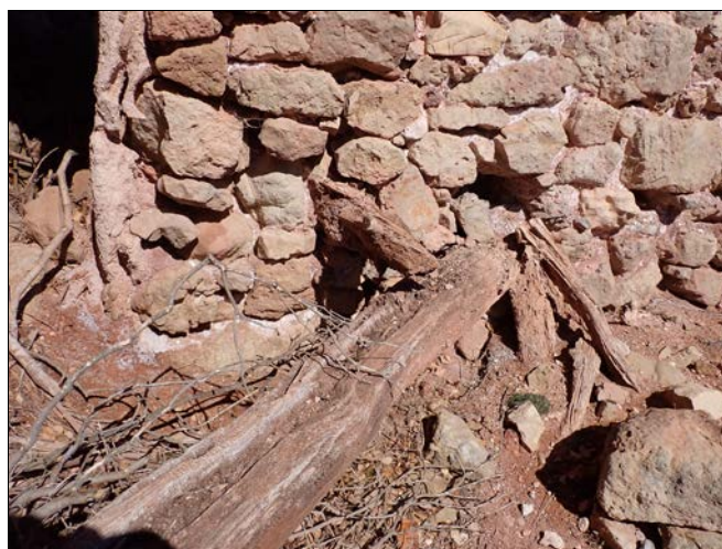
Foto 24. Detall de la biga encara in situ (al fons, mur 1020).
