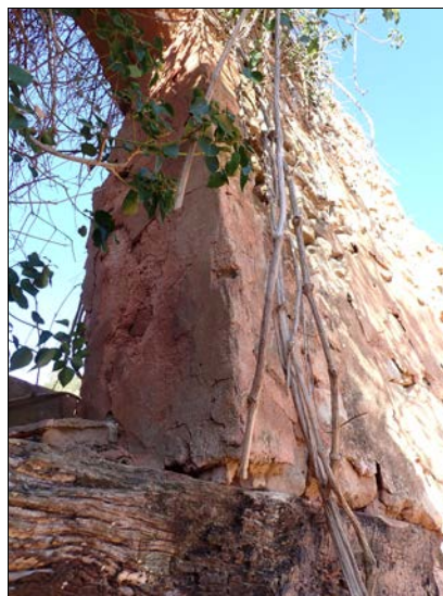
Foto 14. Detall de l'arrebossat que recobreix un dels brancals de la porta 1012.
