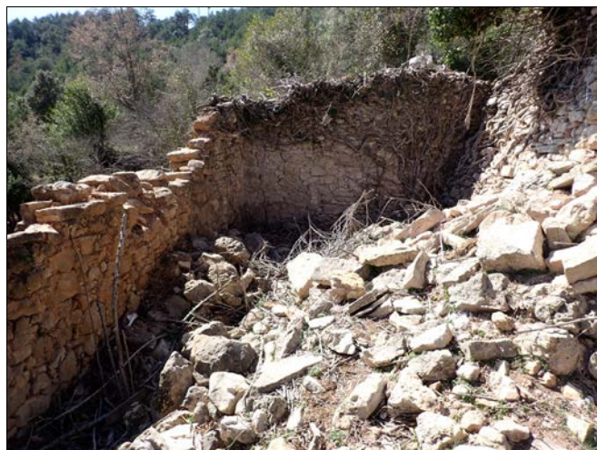
Foto 79. Angle SO de l'àmbit: punt d'unió dels murs 1046 i 1037.
