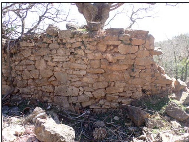
Foto 76. Parament interior del mur 1037 (mur de tancament SE).
