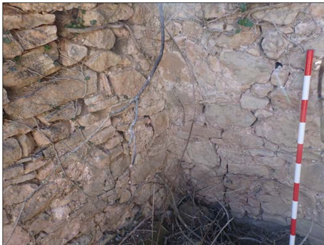
Foto 81. Punt d'unió entre els murs 1037 i 1046.
