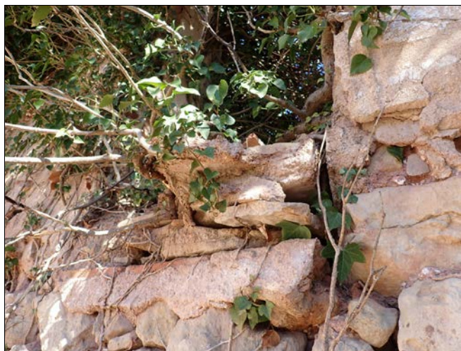
Foto 31. Marxapeu de la porta 1030 amb restes del forjat de morter i pedres.
