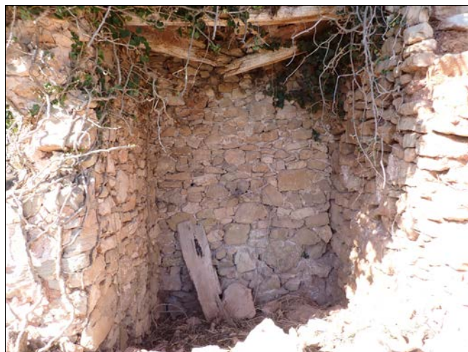
Foto 63. Mur 1007 (al fons) i murs 1002 i 1009 als laterals.
