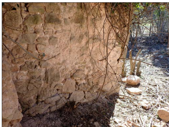
Foto 65. Mur que tanca el costat NE de l'àmbit (1051).
