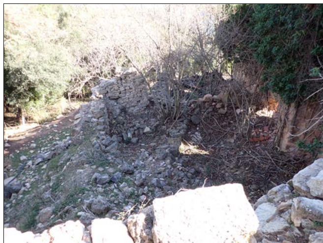
Foto 91. Mur 1005 vist des de l'exterior: portes 1003 (planta baixa) i 1012 (primera planta).
