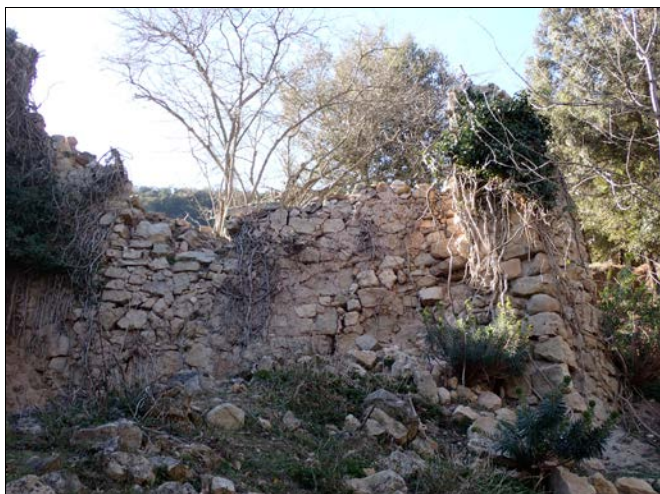
Foto 92. Vista del mur 1058 des de l'interior de l'àmbit K (vista des del S). A la dreta, contrafort 1059.
