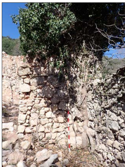
Foto 68. Mur 1022 (àmbit D) al qual se li adossa el mur 1034 (dreta).
