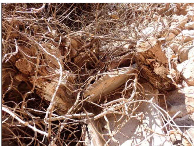
Foto 23. Restes del forjat de la planta superior amb paviment de lloses (cantonada murs 1005-1020).
