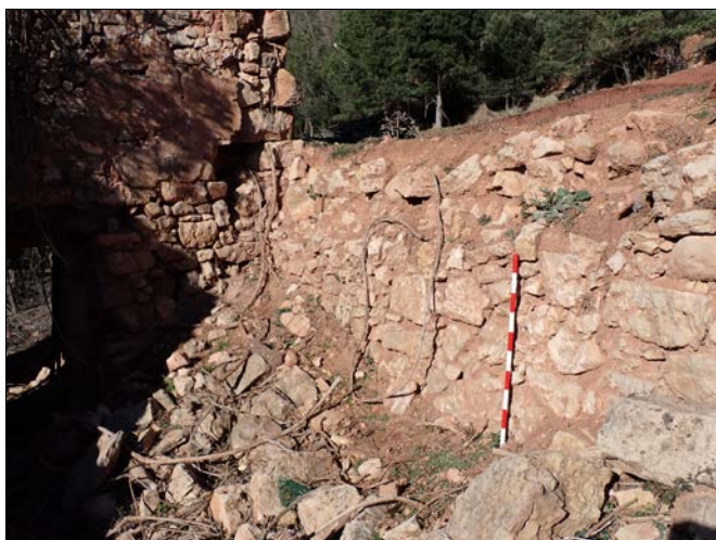
Foto 11. Mur 1013 i punt d'unió amb el mur 1005.
