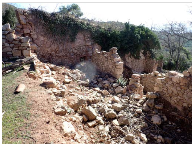
Foto 15. Vista de l'interior de l'àmbit B des de l'era.
