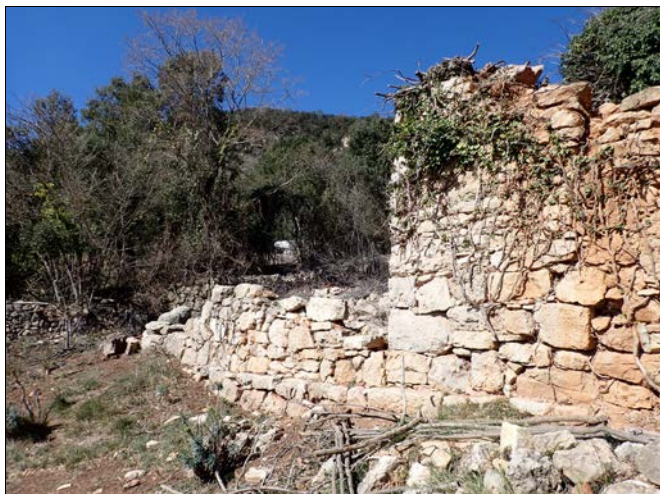
Foto 74. Cantonada SO de l'àmbit vist des de l'exterior: a l'esquerra, mur 1037, a la dreta, mur 1069.
