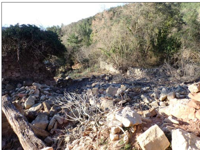
Foto 3. Interior del mas mirant cap a l'exterior en direcció oest.
