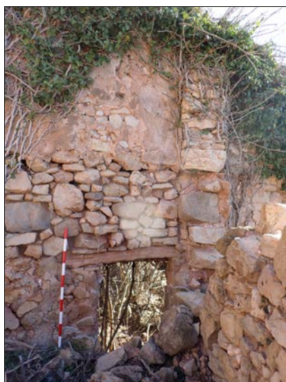
Foto 17. Porta 1018 oberta a la paret 1015. A la dreta, unió del murs 1015 i 1020.
