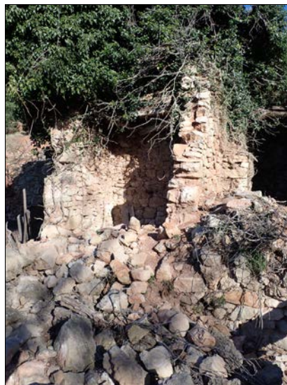
Foto 61. Vista de l'àmbit I des de l'àmbit G.
