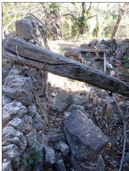
Foto 100. A l'esquerra, mur de tancament NE (1064) i restes d'un pilar adossat (1068).
