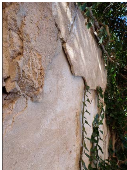
Foto 33. Capes de revestiment del parament 1025 a nivell de primera planta.
