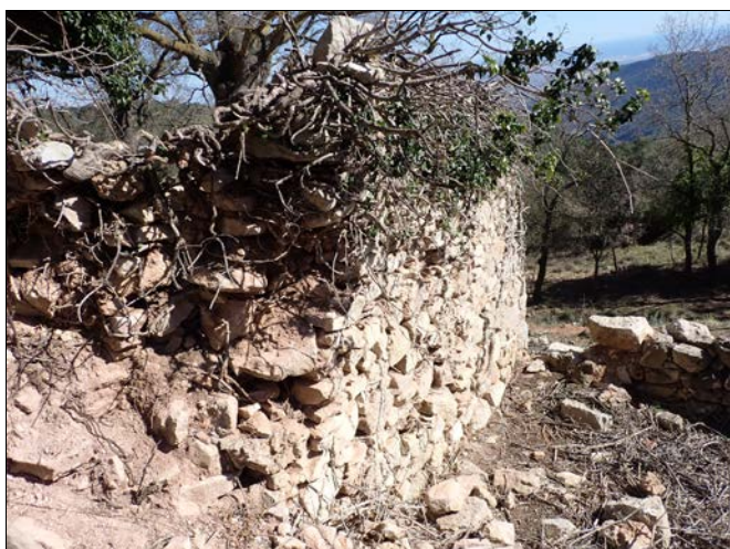
Foto 82. Mur de façana 1046 (tancament SO).
