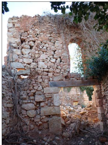
Foto 8. Mur 1005 vist des de l'exterior: portes 1003 (planta baixa) i 1012 (primera planta).
