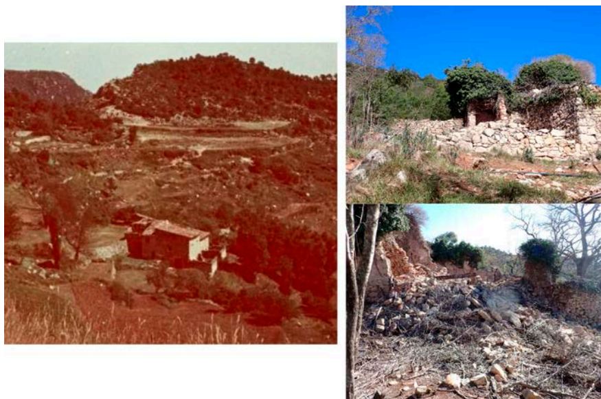
Figura 3 | A l'esquerra fotografia dels anys 70/80 amb la gran majoria del conjunt d'edificis del Mas del Favat encara dempeus (imatge proporcionada per la propietat). A la dreta, imatges que il·lustren l'estat actual ruïnós del mas.
