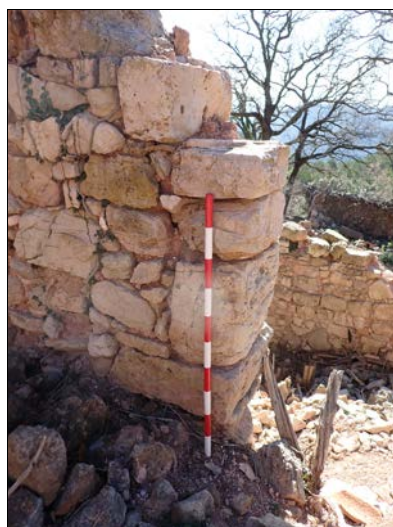
Foto 12. Brancal NE de la porta 1017 oberta en el mur 1020.
