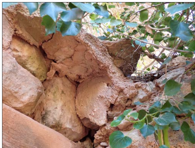
Foto 41. Restes del forjat de la primera planta de l'àmbit A (mur 1005).
