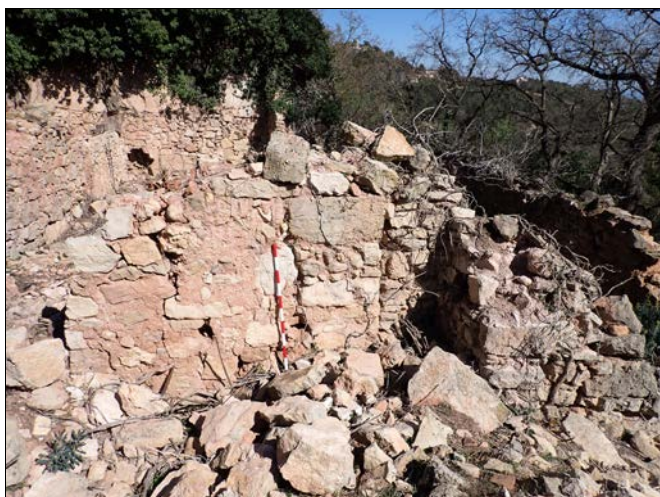
Foto 44. Cantonada SE de l'àmbit amb els elements que la integren (1005, 1042, 1040).
