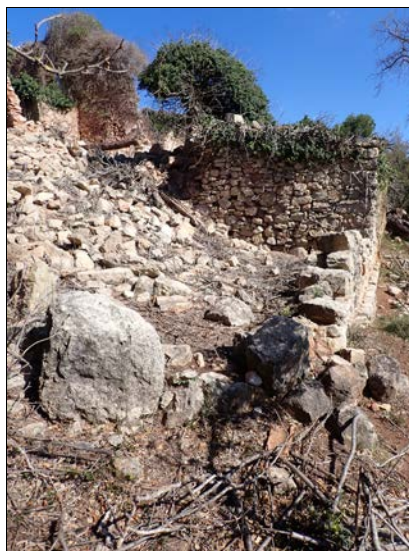
Foto 75. En primer pla, mur 1069. Al fons, mur de façana 1046.
