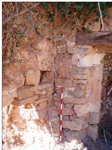
Foto 10. Punt d'unió entre els murs 1005 i 1020.
