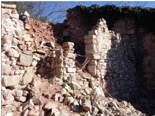
Foto 19. Portes 1017 i 1032 en el mur 1020 vistes des de l'àmbit C.
