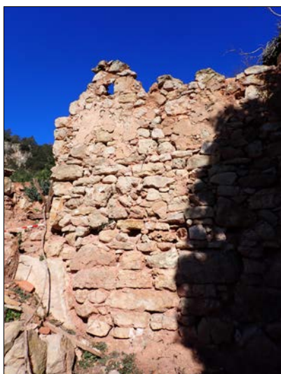
Foto 21. Mur 1020 amb els encaixos de la bigues del forjat de la primera planta.
