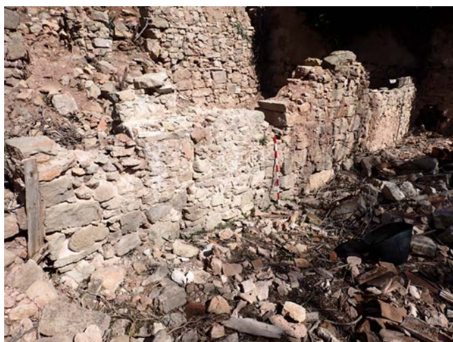
Foto 34. Estructures que defineixen el costat NO de l'àmbit (1029, 1028, 1027 i 1026).
