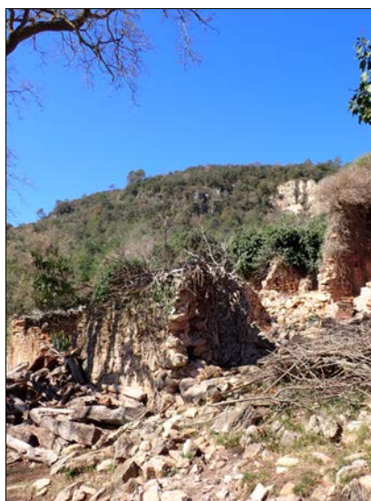
Foto 73. Punt d'unió entre el mur 1037 i el mur 1036 (cantonada SE de l'àmbit).
