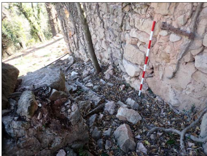
Foto 98. Mur de tancament SE (1066) amb porta 1067. Al fons, mur 1025.
