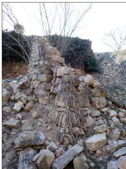
Foto 101. Mur 1066 amb contrafort atalussat 1065.
