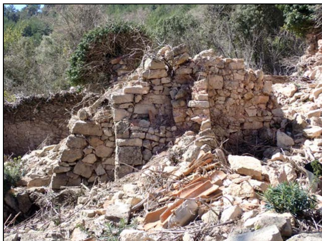
Foto 48. Vista del conjunt de contraforts (1040, 1041) de la cantonada SO de l'àmbit.
