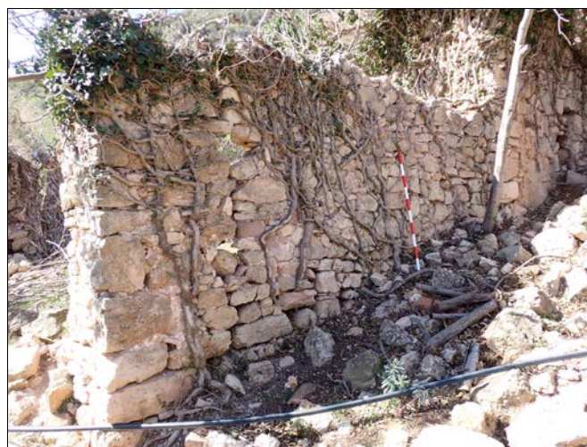
Foto 71. Vista del mur 1034 des de l'exterior del mas.
