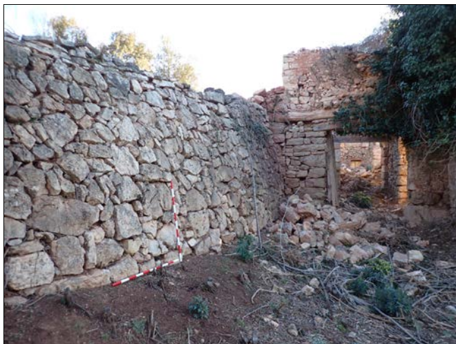
Foto 36. A l'esquerra, marge de pedra seca 1001, a la dreta, mur de façana de l'àmbit A (1010) i porta 1006.
