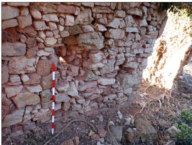
Foto 40. Mur de tancament SE (1007).
