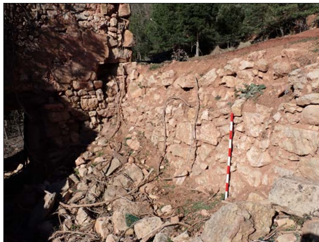
Foto 16. Mur de terraplenament que defineix el lateral NO de l'àmbit (1013).
