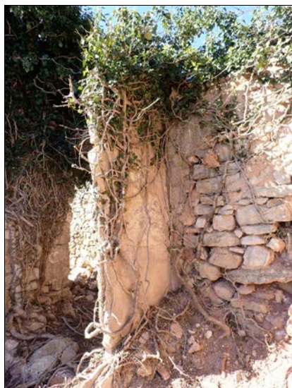
Foto 56. Detall de l'envà fet amb lloses de pedra que dividia l'àmbit H en dos (1056).
