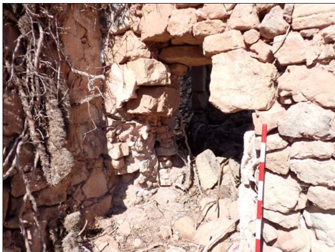
Foto 24. Restes de la porta 1016 (mur 1020).
