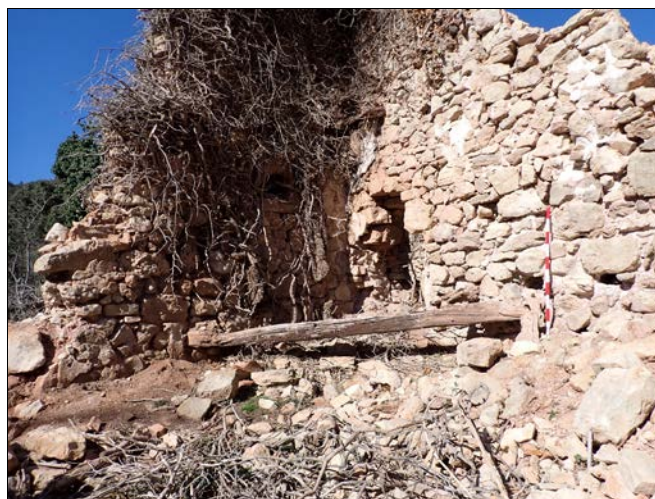
Foto 22. Cantonada d'unió dels murs 1005 i 1020 amb una de les bigues del forjat davant la porta 1016 .
