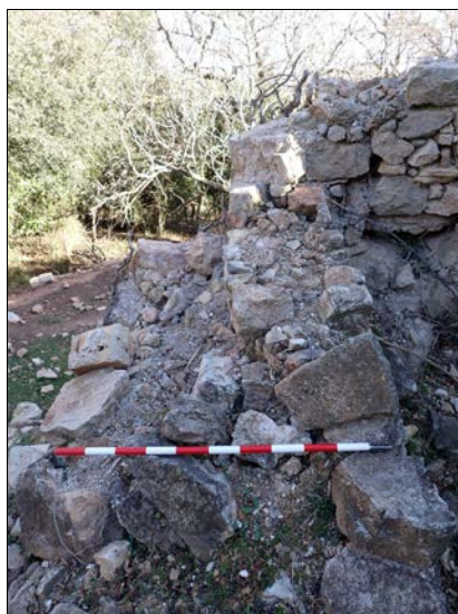
Foto 93. Mur de tancament NE (1060). S'uneix al mur 1062.
