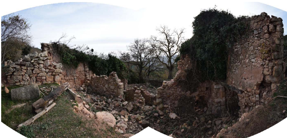
Foto 06. Vista panoràmica des de façana nord
