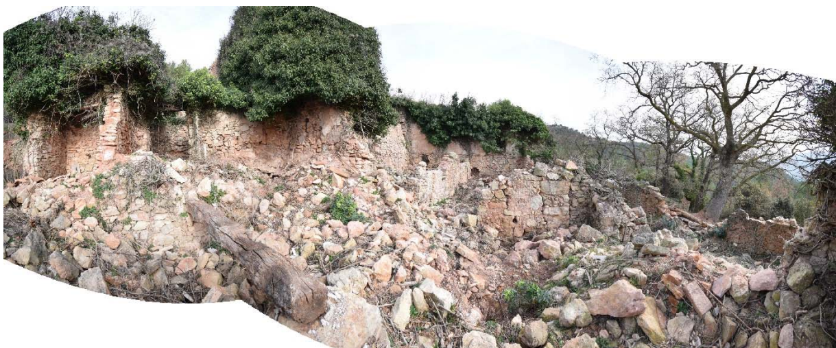
Foto 07. Vista interior panoràmica.
