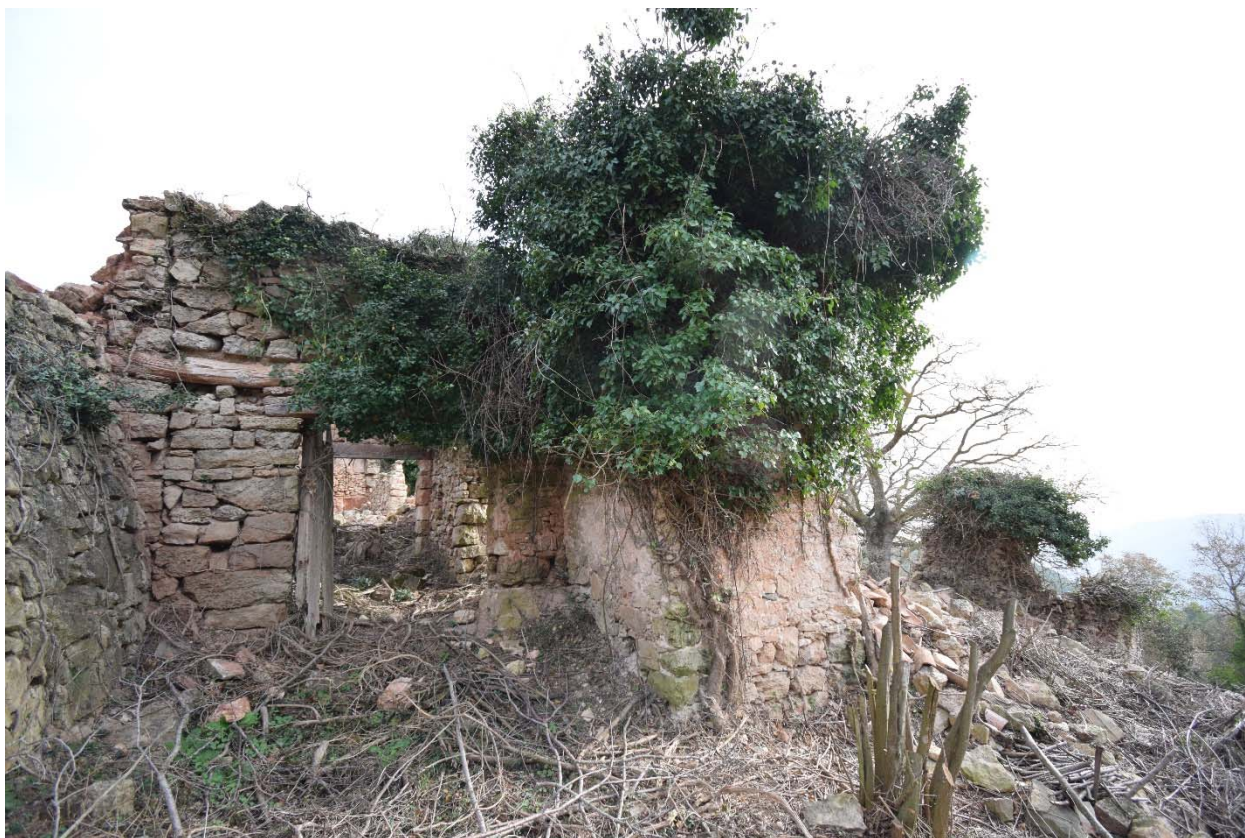
Foto 00. Vista entrada oest
