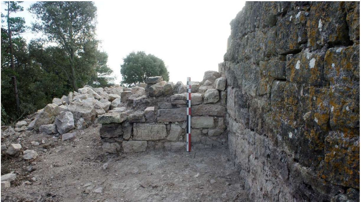
Cantonada nord-oriental de la Sala II
