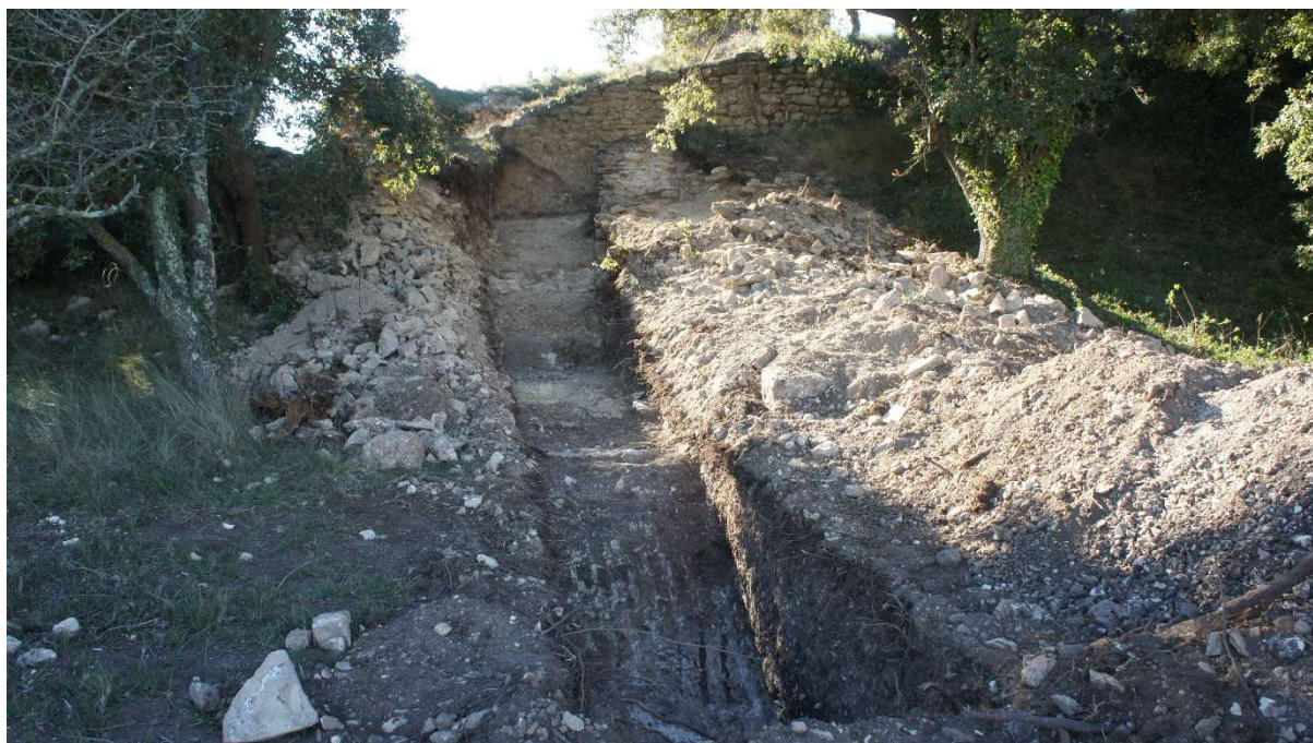
Imatge general de la rasa 1, amb la cisterna al fons
