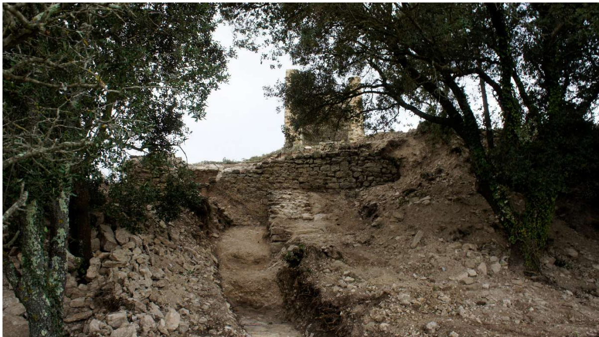
Vista de l'exterior de la cisterna amb indicació de l'inici del possible àmbit contigu a la cisterna
