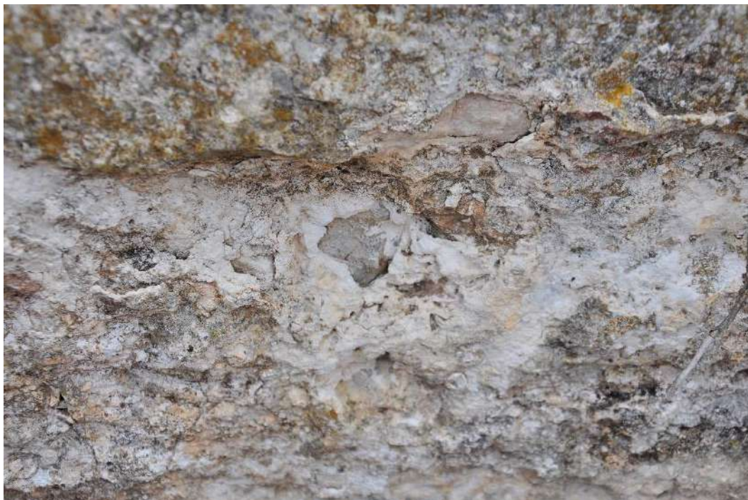
Macrofotografia de la laminació superficial del morter i presència de líquens i fongs. Poca quantitat d'àrid.
