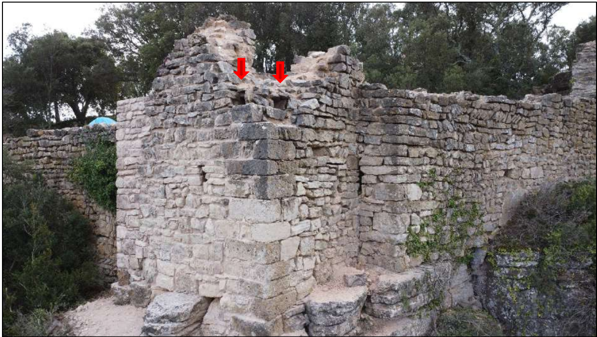
Imatge exterior de la Bestorre I, amb indicació dels dos encaixos de la bastida perimetral
