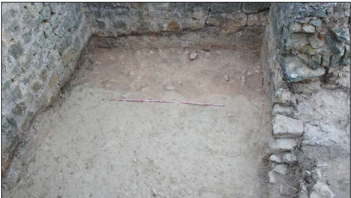
L'interior de l'edifici turriforme amb el retall 503
