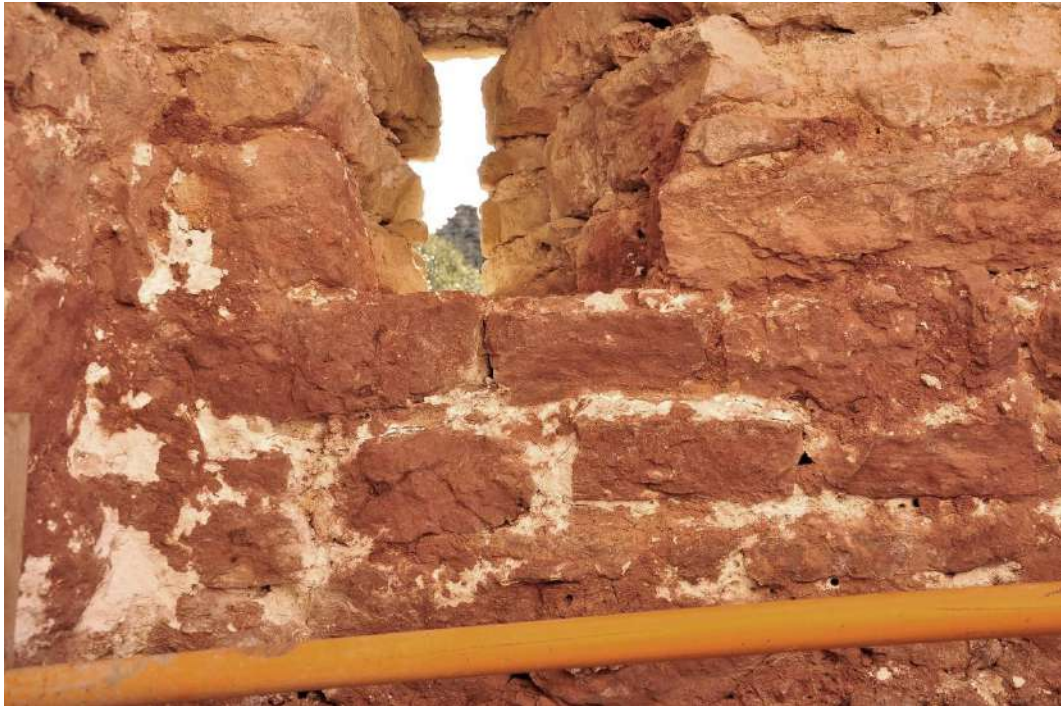
Detall de les restes de morters entre juntes d'unió entre carreus.
