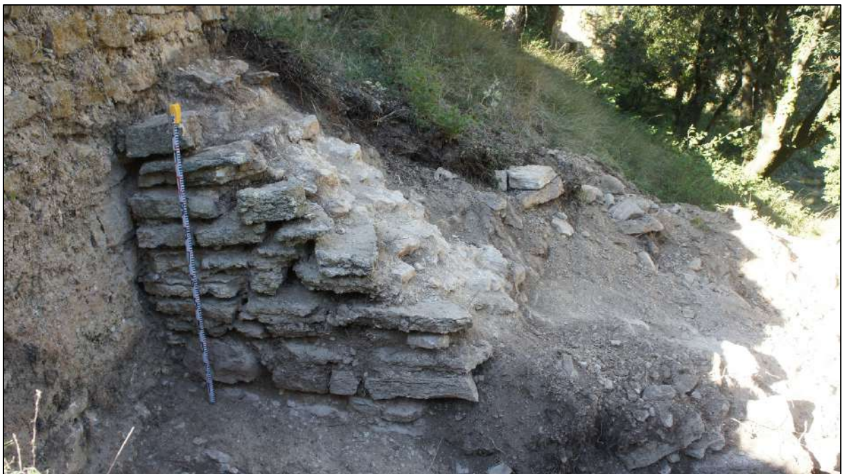
El contrafort exterior de la cisterna
