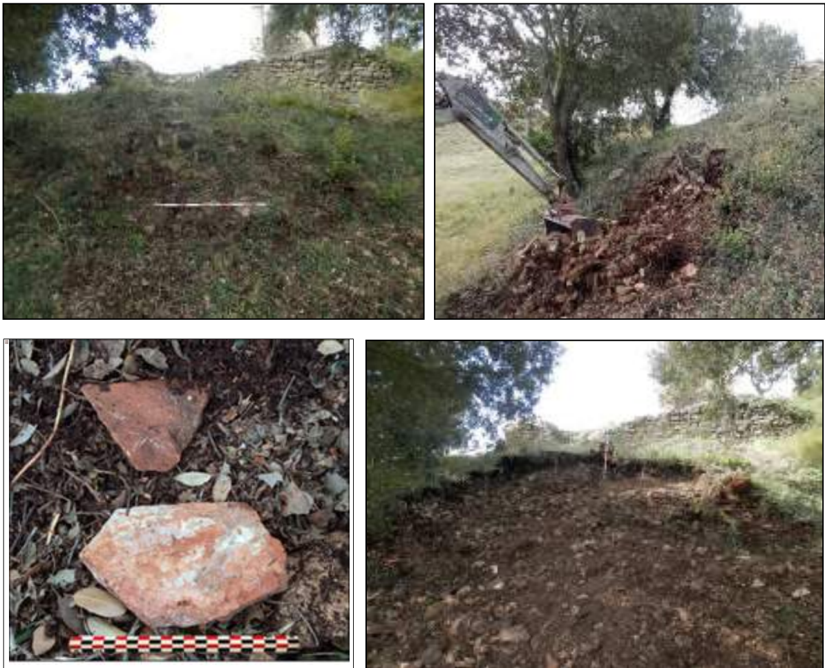
Fig. 13: Fotografies durant el procés d'excavació del nivell d'enderroc (UE 1002) de la zona occidental pròxima a la rasa 1 (R1). Fotografia inicial, durant el procés, el material constructiu aparegut i fotografia final.
