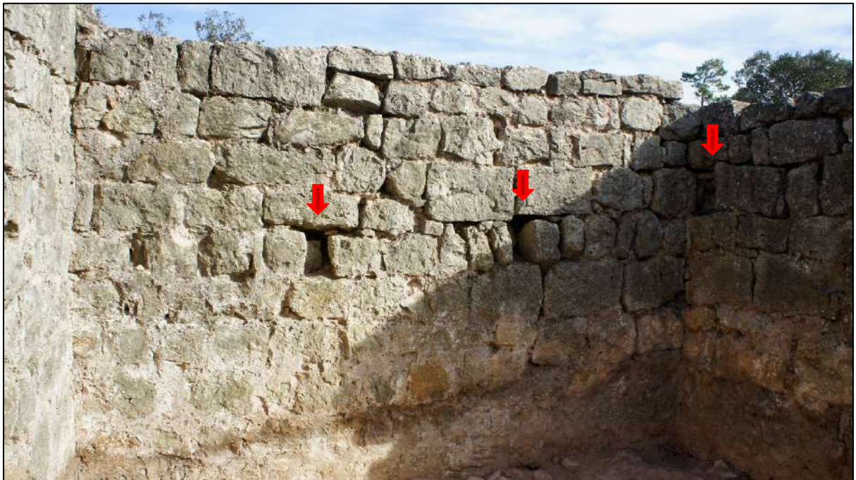
Els encaixos localitzats a l'interior de l'edifici (O-01, 02 i 03)
