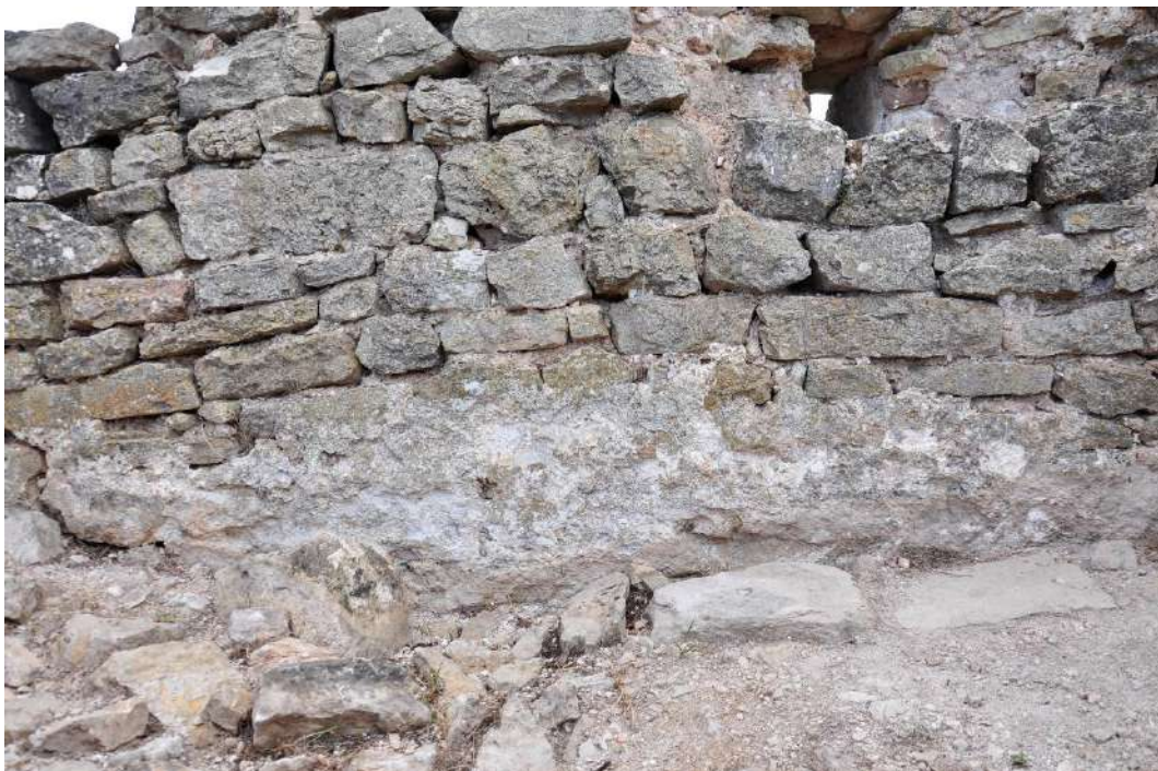
Morter de color blanquinós i amb capa biogènica superficial.
