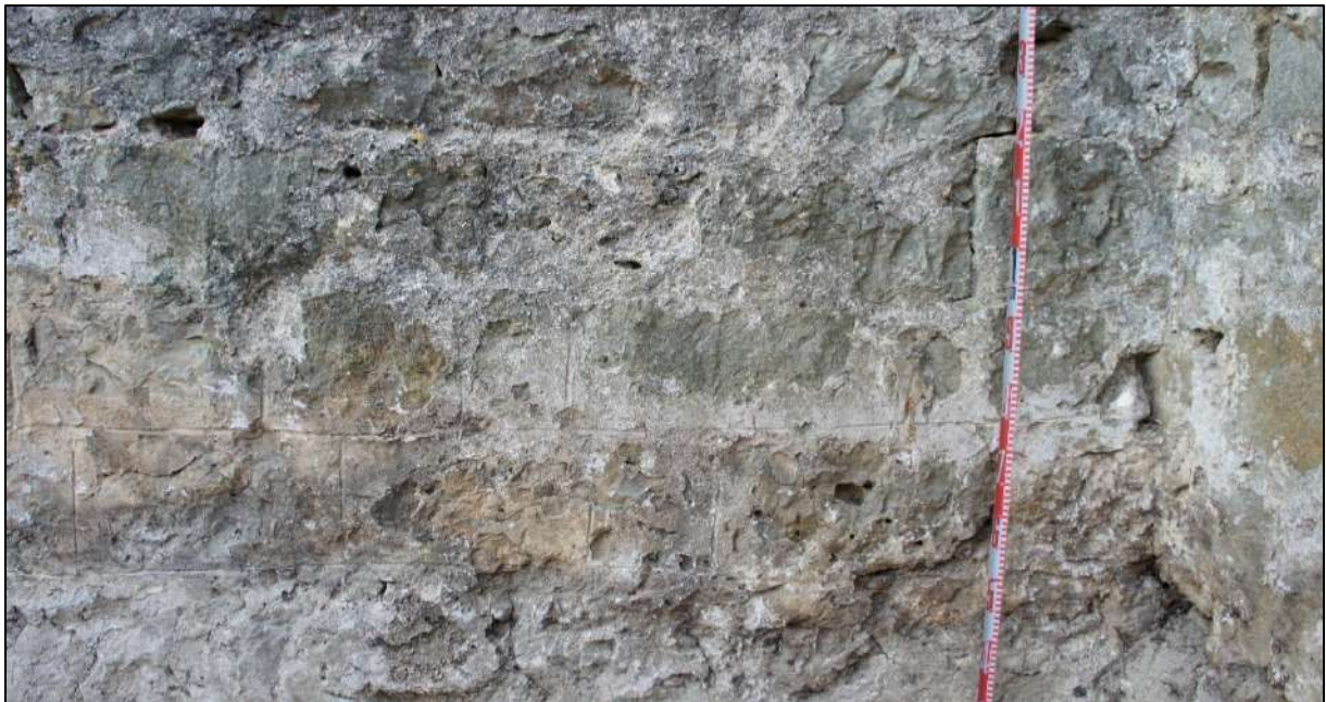
Detall de l'encintat de morter de calç de l'interior de l'edifici.
