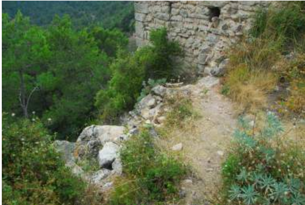
Mur enderrocacat del costat sud.
