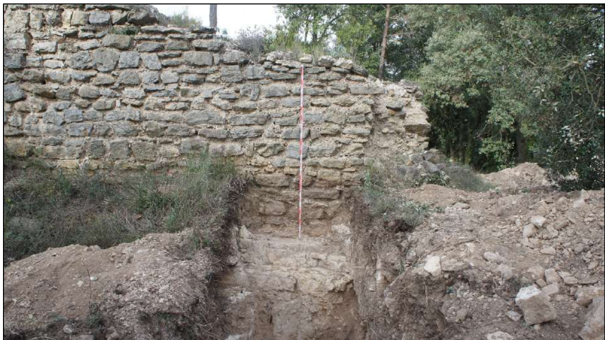
Detall del mur lateral de la cisterna
