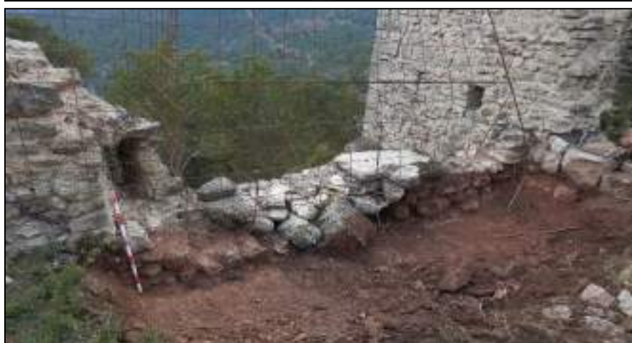
Fig. 11: Fotografies finals a la intervenció al tram oriental de la muralla del Castell d'Albiol.
