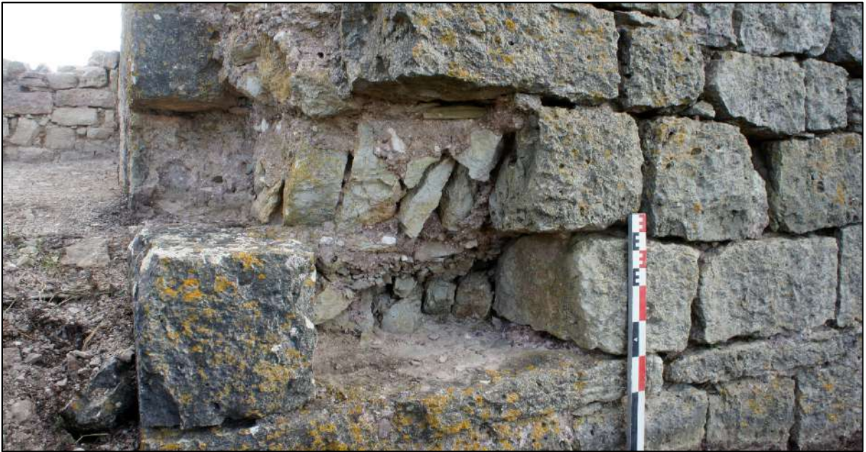
Detall del rebliment interior dels murs
