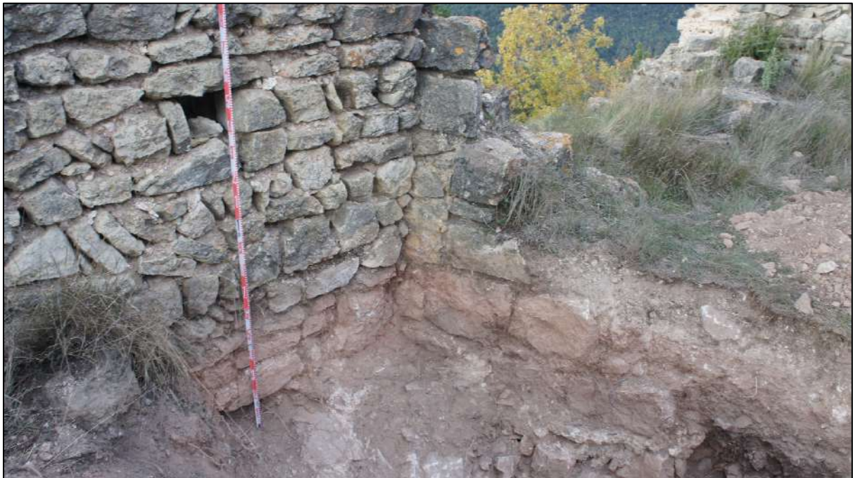
Angle format per la muralla i la bestorre nord-occidental. S'observa força bé com la primera es recolza constructivament a la segona
