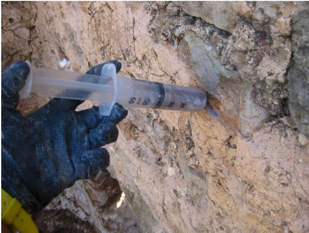
Process d'injecció de morter líquid en zones de separació del morter del mur.
