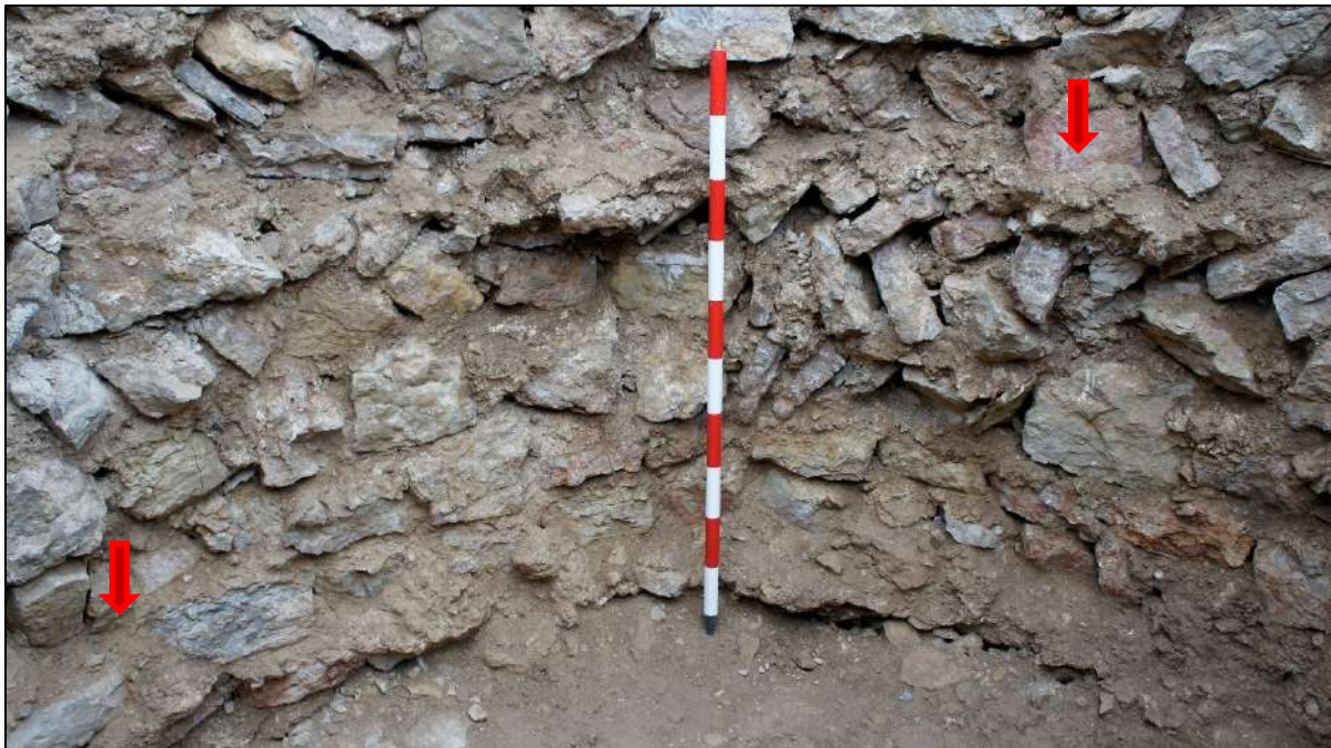
El parament interior de la torre, amb indicació de les rebaves de morter de calç
