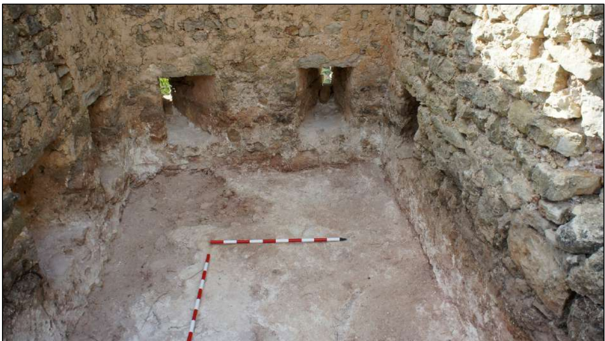
Nivell d'ús original i les espitlleres del mur frontal de la construcció.
