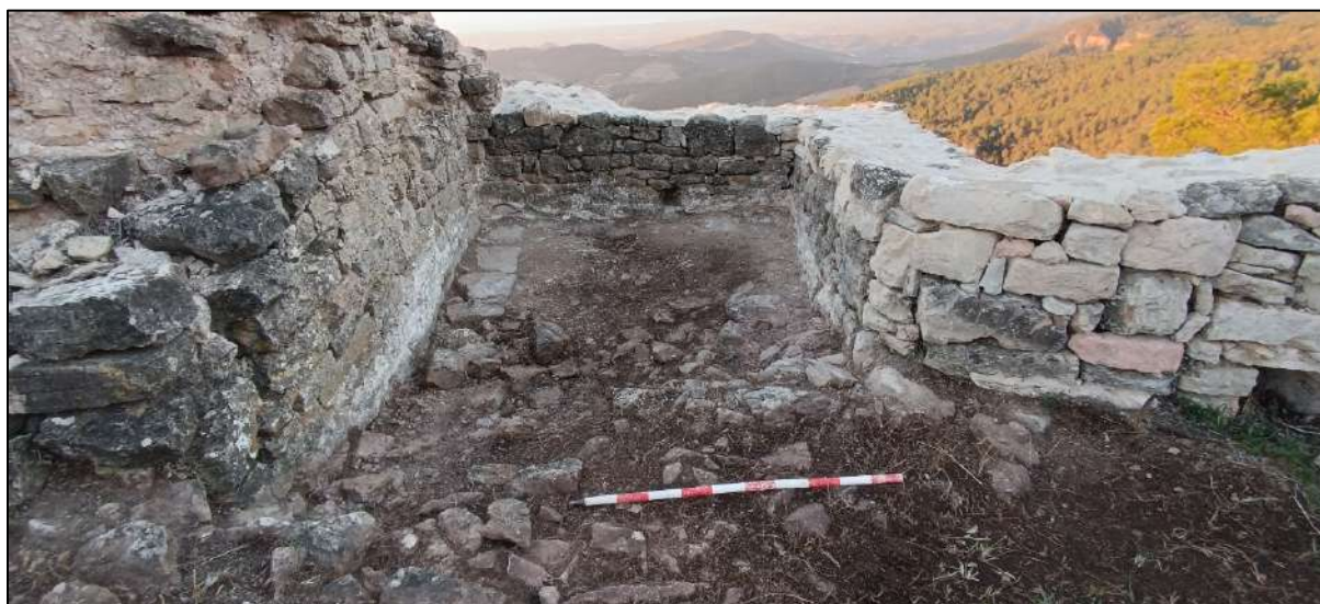
L'interior de la torre després d'una primera neteja superficial
