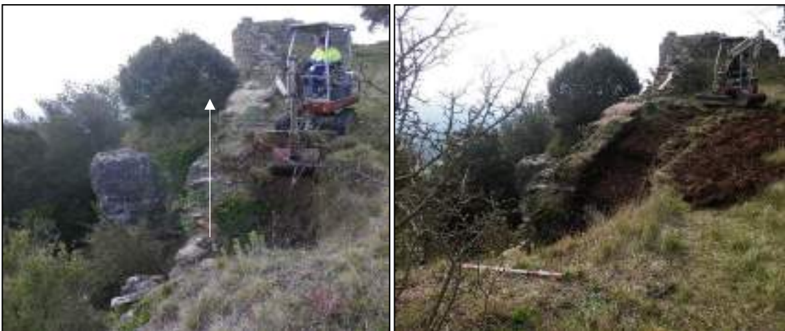
Fig. 6: Fotografies durant el procés d'excavació del nivell superficial (UE 1000) extrem SE.
