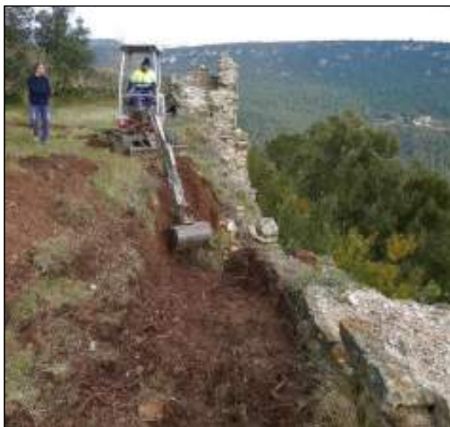
Fig. 7: Fotografia durant el procés d'excavació de la UE 1001, extrem NO.
