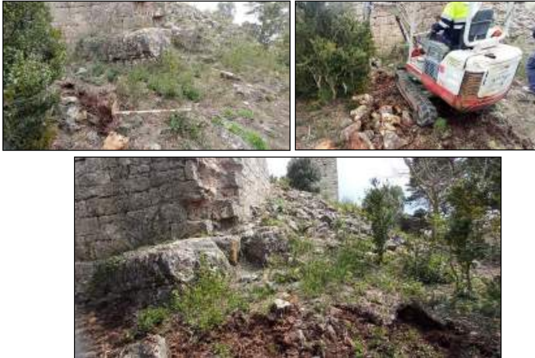
Fig. 14: Fotografies durant el procés d'excavació del nivell d'enderroc (UE 1002) de la zona NO pròxima a una de les torres quadrangulars. Fotografia inicial, durant el procés i final.
