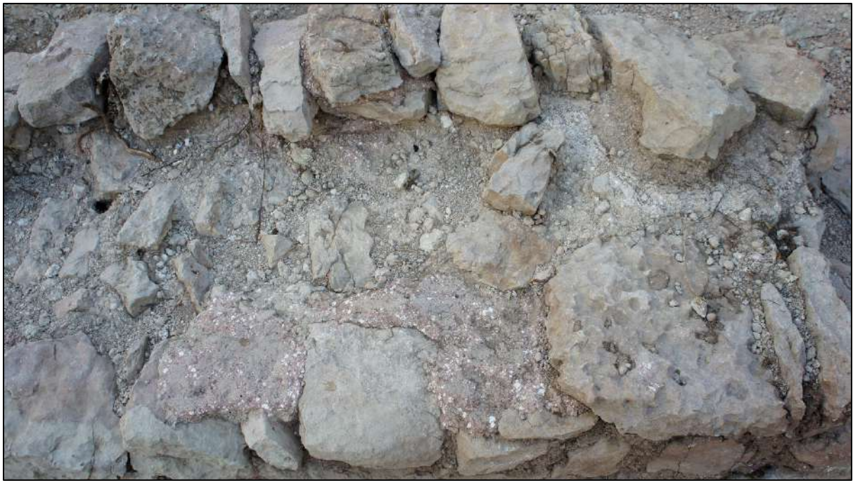
Imatge de detall dels murs de la Sala I, amb els dos tipus de morters identificats
