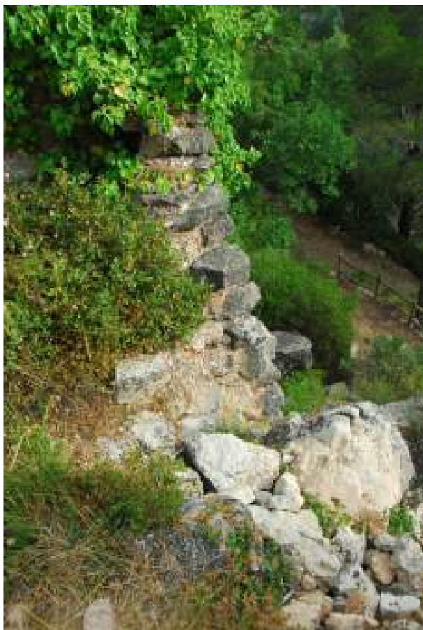
Mur enderrocacat del costat sud.
