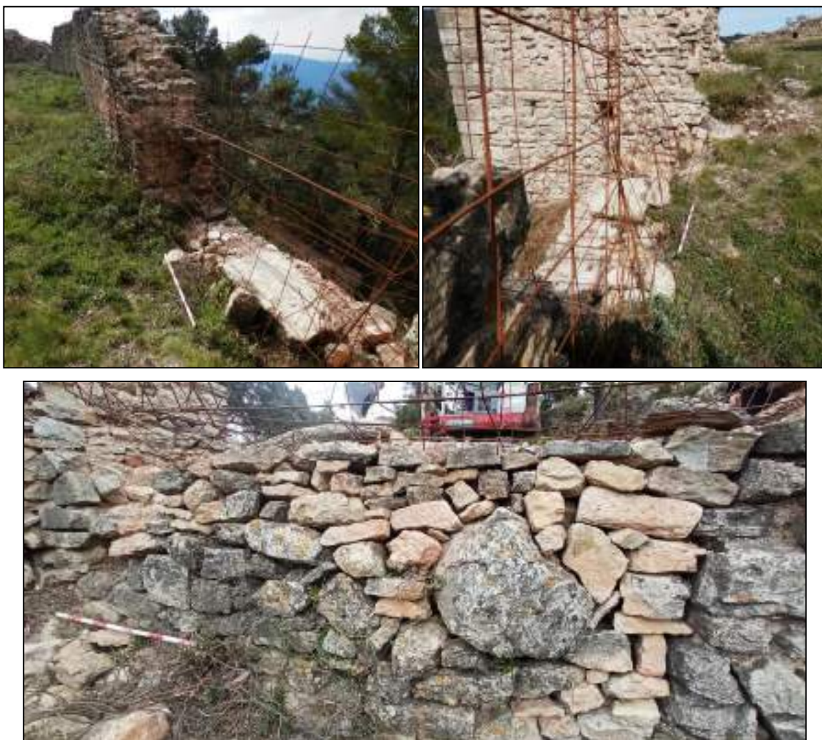
Fig. 10: Fotografies inicials a la intervenció al tram oriental de la muralla del Castell d'Albiol des de dues perspectives interiors (E). Figura inferior: mostra de la part exterior conservada del mur oriental des de sobre la roca geològica.
