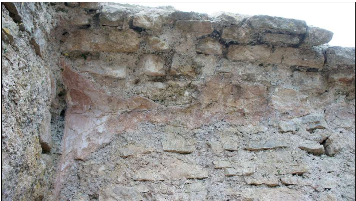
Restes de l'enlluït de morter de calç adossat a la volta de la cisterna
