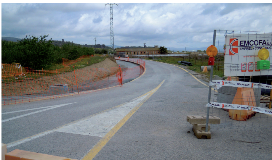
Tram de les obres de la TV 7046b
